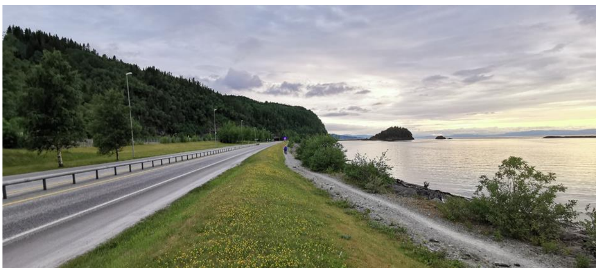
Figur 8: E6 langs Hellstranda og Trondheimsfjorden (Foto: Rambøll, 2020).
