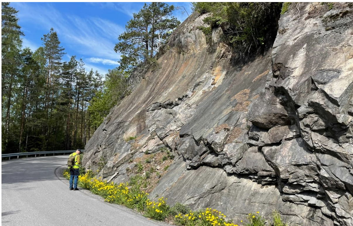
Figur 19-6: Bergskjæring ved Rørholtveien ved ca. profil 17350. Bølgete og glatte foliasjonsplan er fremtredende i bergskjæringen. Sett mot vest. Fotograf: Ingvild Sangesland Qvist.
