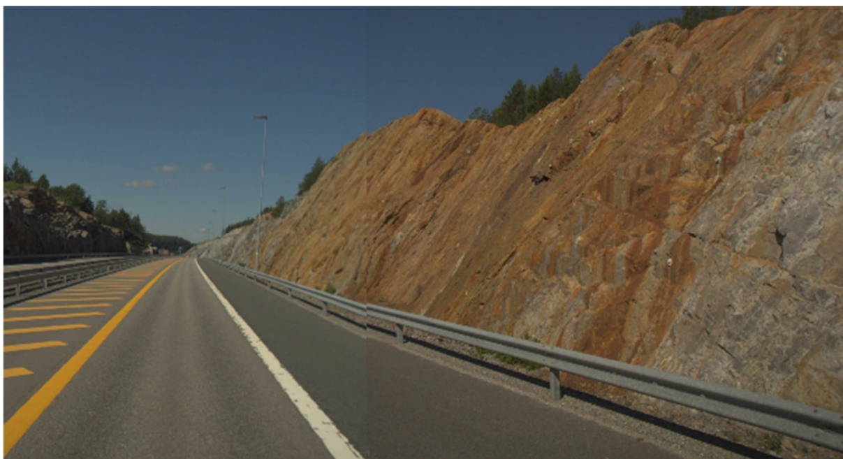
Figur 19-9: Bergskjæring ved dagens E18, ca. 150 m øst for profil 18500 (som er slutten på E18 Kragerø-Bamble-strekningen). Sett mot sørvest. Kilde: [18].
