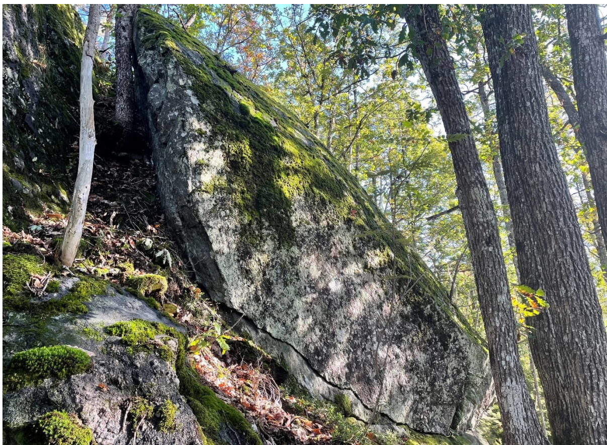
Figur 15-11: Ustabil blokk som er registrert ved ca. profil 12282-12300 i overkant av bergskjæring 10000_VS_34. Sett mot øst. Fotograf: Ingvild Sangesland Qvist.
