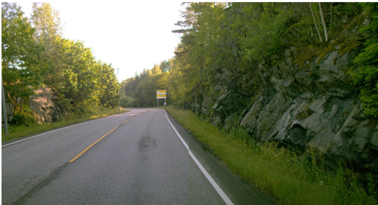
Figur 12-7: Dagens bergskjæring ved sidevei (VIPS-nr. 22182) ved ca. profil 150 (der bergskjæring 22182_VS_20 kommer). Foliasjonsplanene (sprekkesett 1) ses tydelig i høyre side av bildet. Sett mot nord (nordøst). Kilde: [18].
