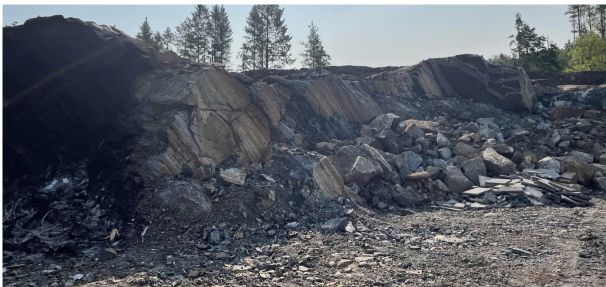
Figur 10-6: Eksisterende bergskjæring ved Fikkjebakke som viser tydelig benkning langs foliasjon. Bildet er tatt ved ca. profil 3400 mot sørøst. Fotograf: Ingvald Sangesland Qvist.
