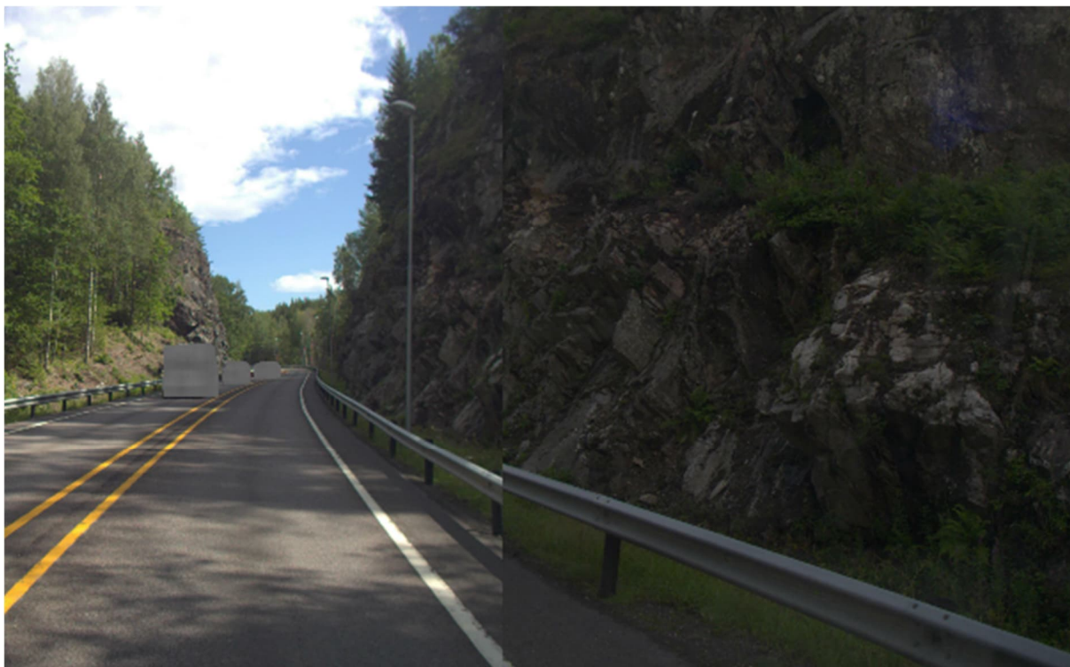
Figur 15-8: Dagens bergskjæringer ved E18 ved ca. profil 13000 (omtrent der bergskjæring 10000_HS_38 kommer). Dagens vei vil utvides langs denne strekningen. Sett mot øst. Kilde: [18].
