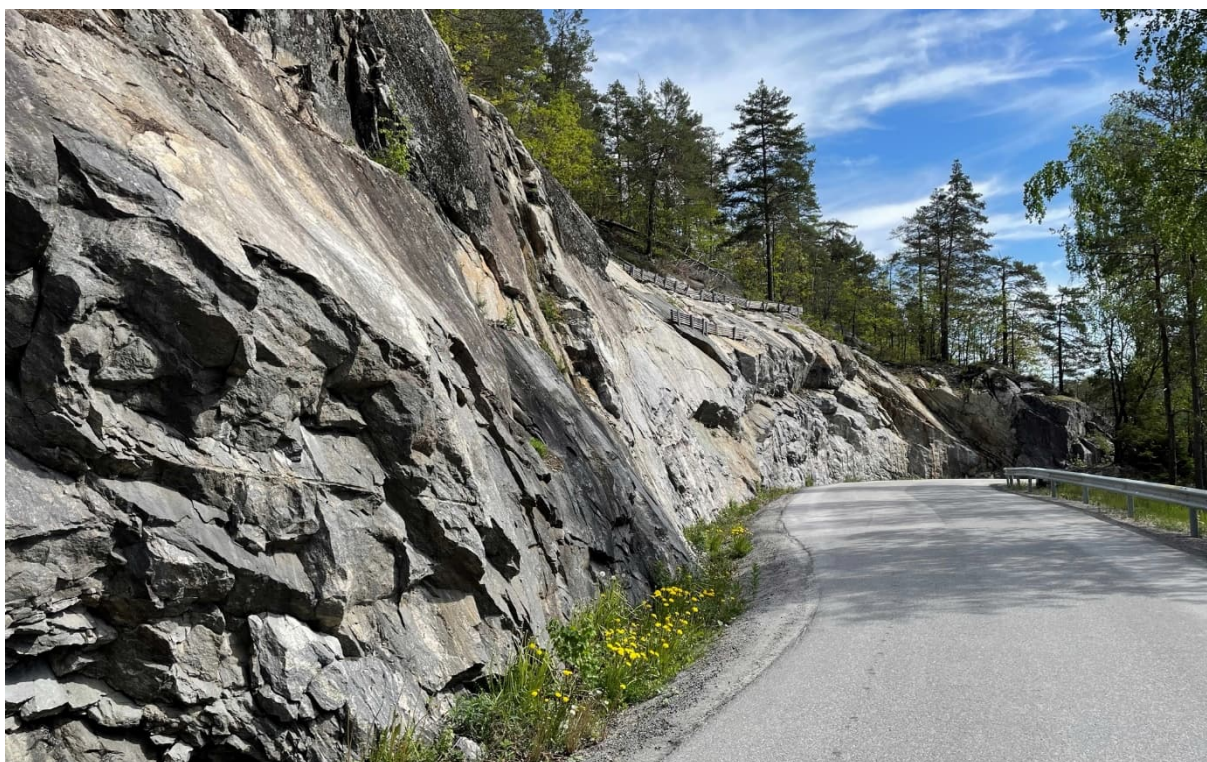
Figur 19-5: Oversiktsbilde av bergskjæring ved Rørholtveien som går parallelt med dagens E18 ved ca. profil 17350. Fremtidig E18 skal trekkes lengre nord, og denne veien forsvinner. Sett mot øst(nordøst). Fotograf: Ingvild Sangesland Qvist.
