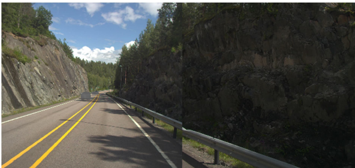
Figur 15-7: Dagens bergskjæringer ved E18 ved ca. profil 12600 (omtrent der bergskjæring 10000_VS_34 kommer). Dagens vei vil utvides langs denne strekningen. Sett mot øst. Kilde: [18].
