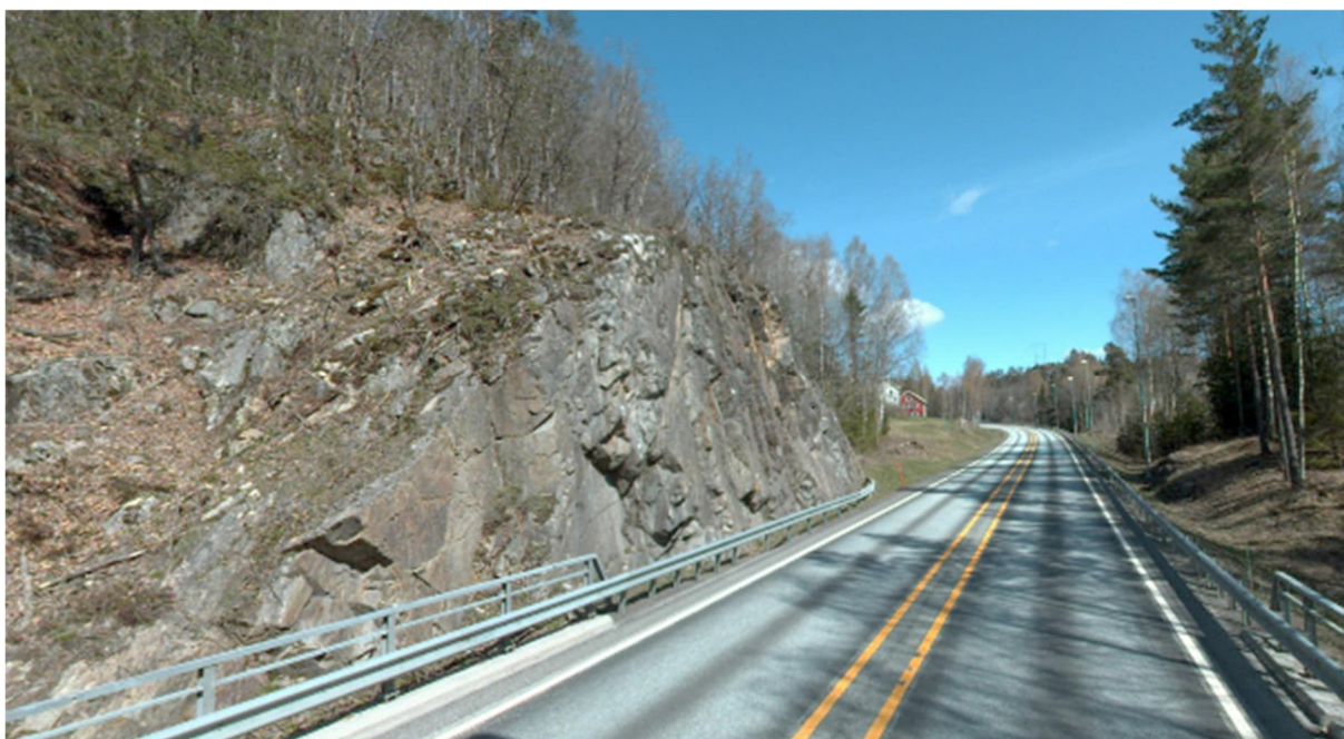
Figur 11-8: Bergskjæring langs dagens E18 ved ca. profil 6500 (der bergskjæring 10000_VS_18 kommer). Dagens vei vil utvides langs denne strekningen. Sett mot nordøst. Kilde: [18].
