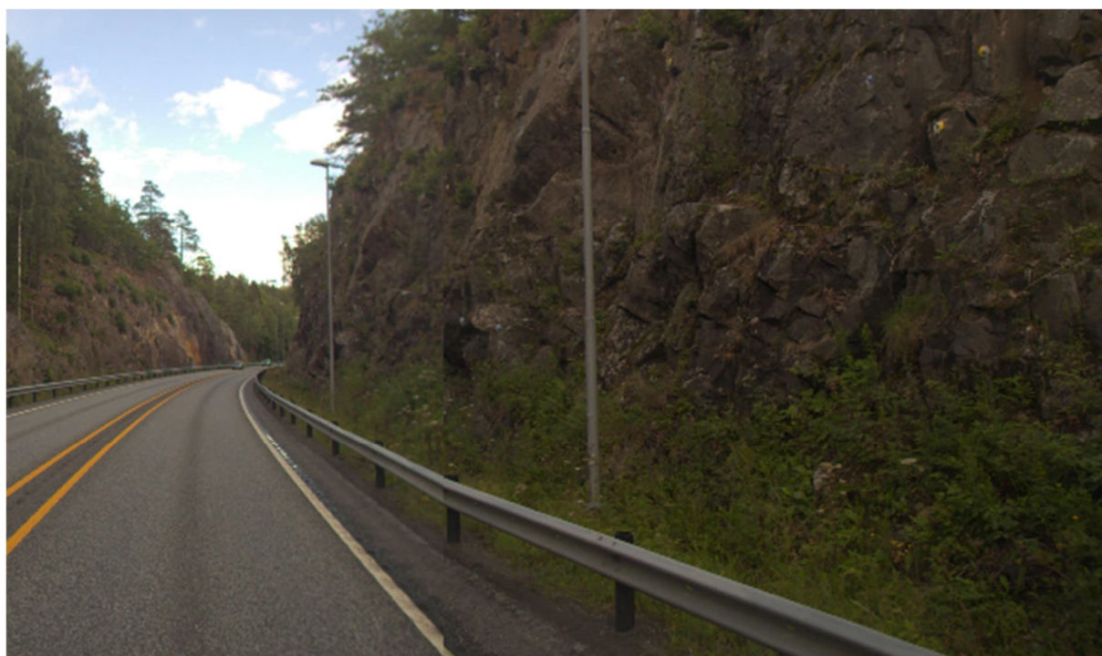
Figur 14-5: Dagens bergskjæring ved E18 ved ca. profil 11300 (der bergskjæring 63022_HS_31 kommer). Dagens vei vil utvides langs denne strekningen. Sett mot nordøst. Kilde: [18].
