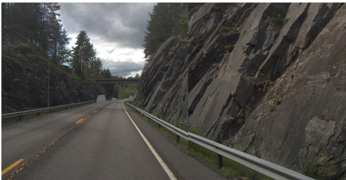
Figur 16-9: Dagens bergskjæringer ved E18 ved ca. profil 15350 (der bergskjæring 10000_VS_45 kommer). Dagens vei vil utvides langs denne strekningen. Sett mot sørvest. Kilde: [18].
