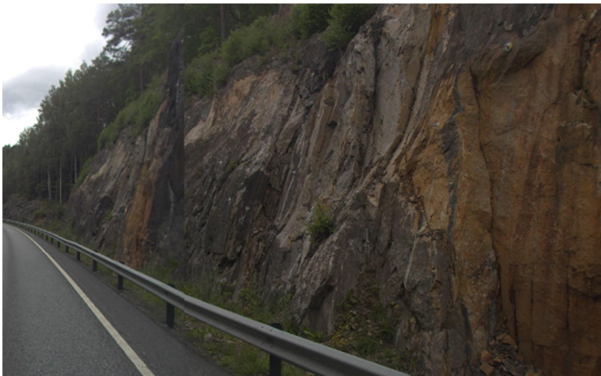
Figur 14-6: Bergskjæring langs dagens E18 ved ca. profil 11450 (der bergskjæring 10000_VS_32 kommer). Dagens vei vil utvides langs denne strekningen. Sett mot sørvest. Kilde: [18].
