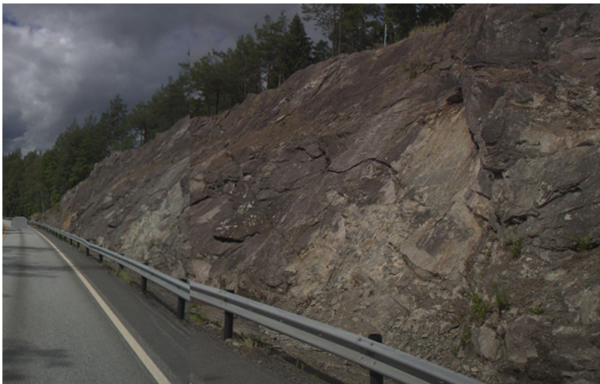
Figur 18-4: Dagens bergskjæringer ved E18 ved ca. profil 16700 (der bergskjæring 10000_VS_42 kommer). Dagens vei vil utvides langs denne strekningen. Sett mot vest. Kilde: [18].
