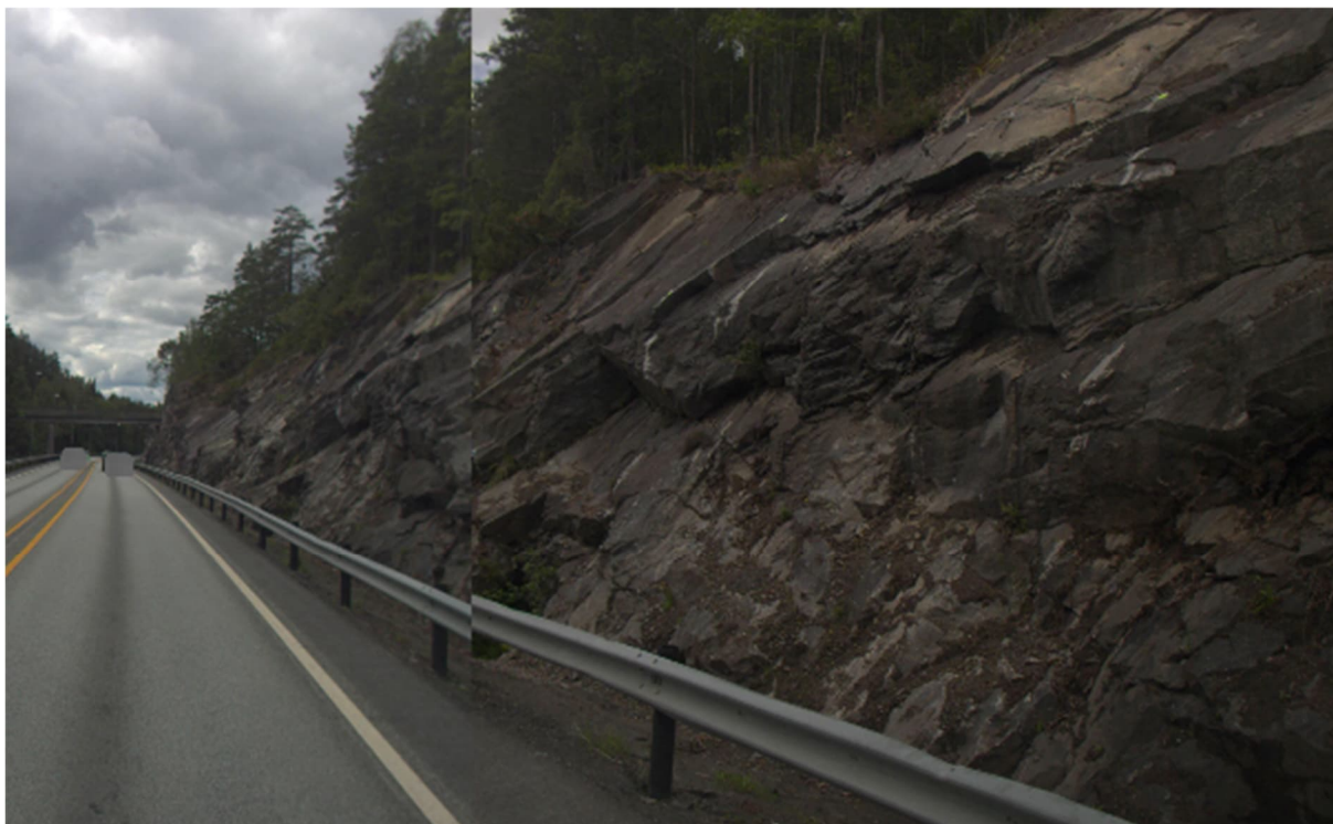
Figur 19-8: Bergskjæring ved dagens E18 ved ca. profil 17550 (der bergskjæring 10000_VS_44 kommer). Dagens vei vil utvides langs denne strekningen. Sett mot vest (sørvest). Kilde: [18].
