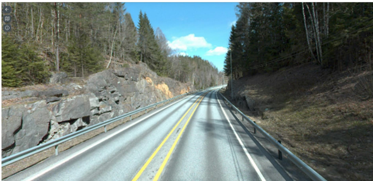
Figur 11-7: Bergskjæringer langs dagens E18 ved ca. profil 6200 (der bergskjæring 10000_VS_17 kommer). Dagens vei vil utvides langs denne strekningen. Sett mot nordøst. Kilde: [18].
