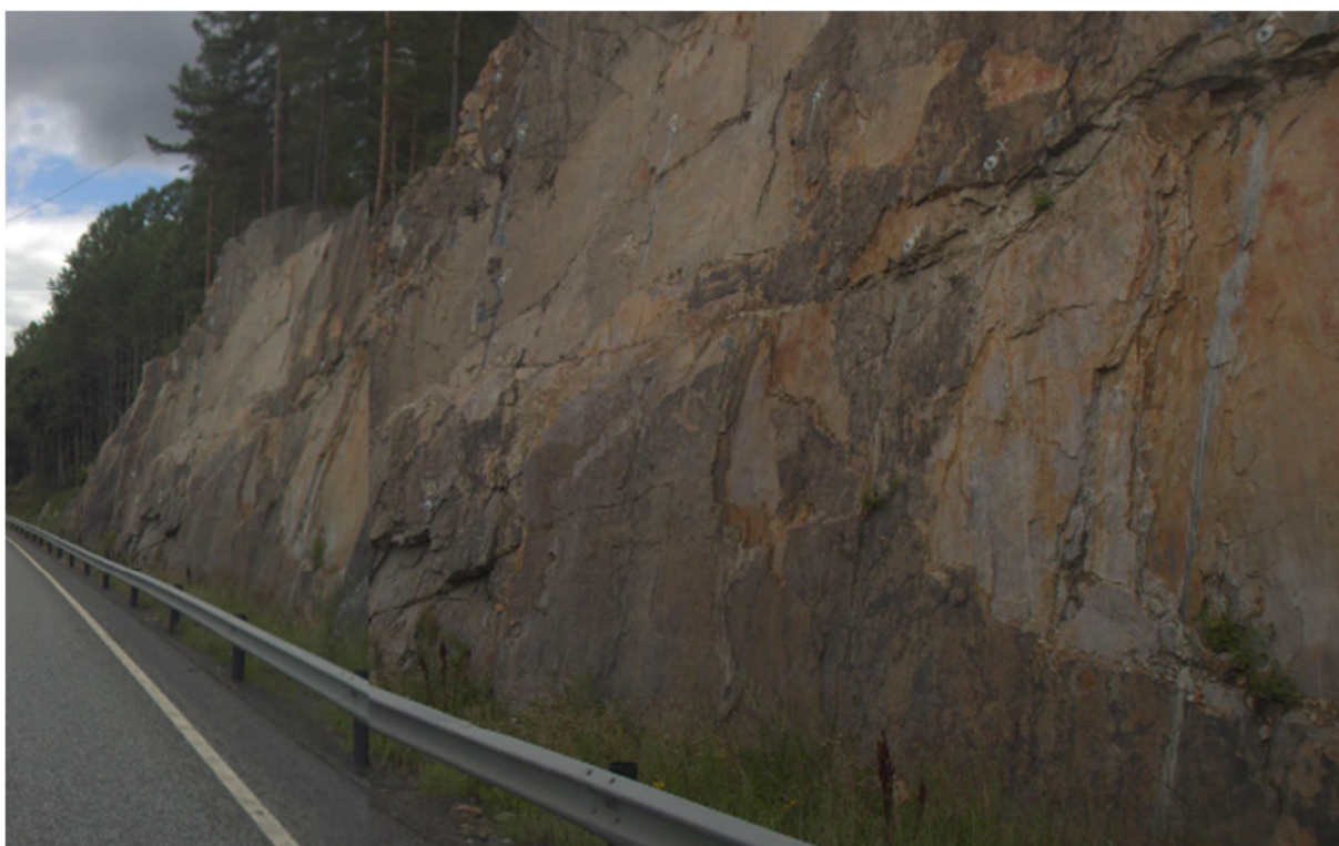
Figur 14-7: Bergskjæring langs dagens E18 ved ca. profil 11800 (der bergskjæring 10000_VS_33 kommer). Fremtidens bergskjæring vil gå parallelt ca. 50 meter nord for dagens bergskjæring. Sett mot vest. Kilde: [18].
