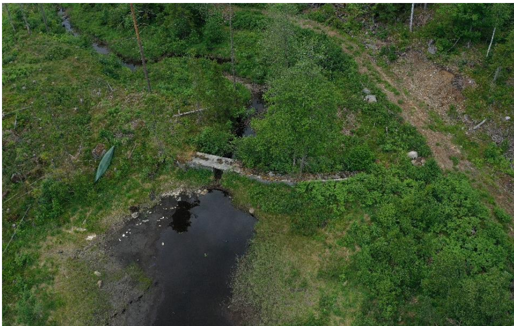
Figur 5.16. Demning ved Baltjern (kilde: Sweco).
