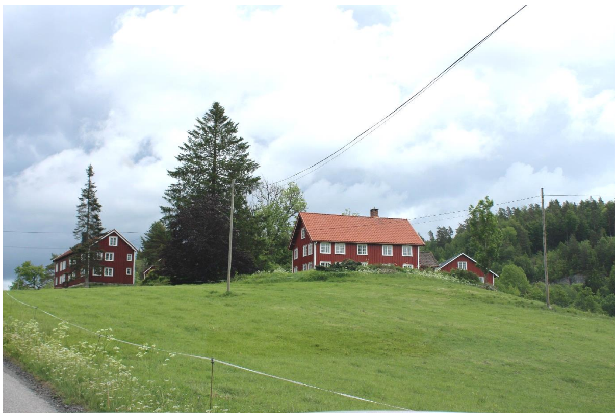
Figur 5.8. Tveite gård. Hus fra fjerde halvdel av 1600-tallet til venstre (ID 0914-0205-048), (kilde: Sweco).
